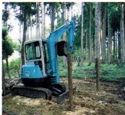
バックホー小屋の支柱用の杭をバケットで打ち込む
